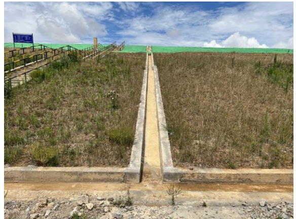
坝体表面纵、横向排水沟
