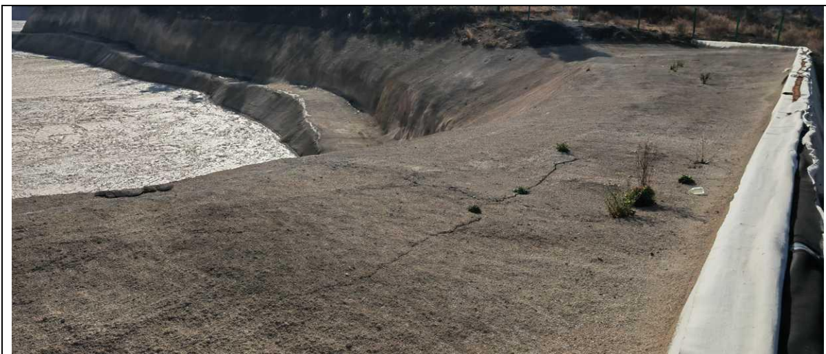
1#副坝坝及内坡（表面已采用喷锚方式防渗）
