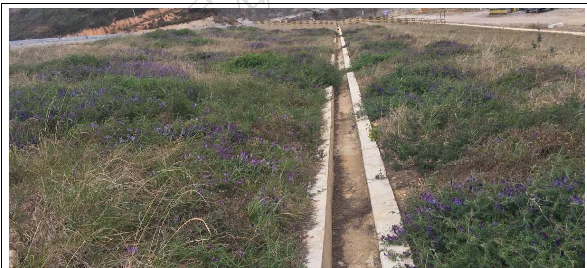
三期第 2 级子坝外坡
