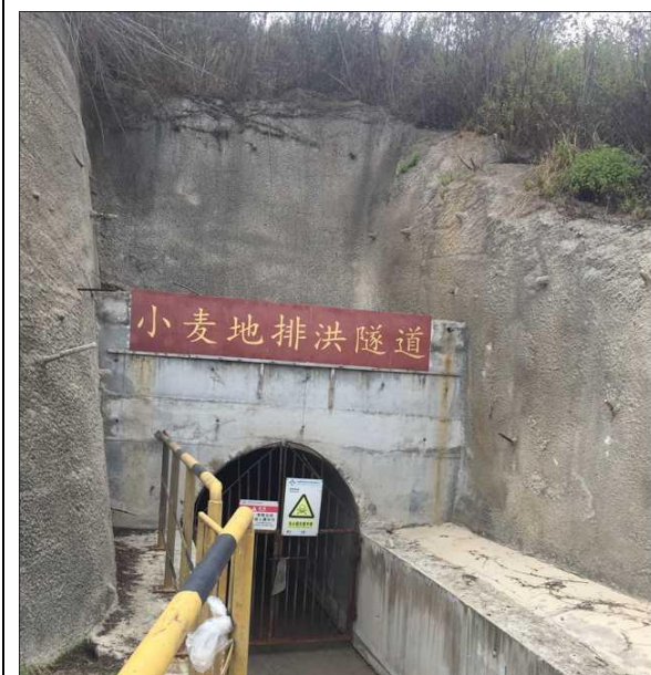
三期排水隧洞出口
