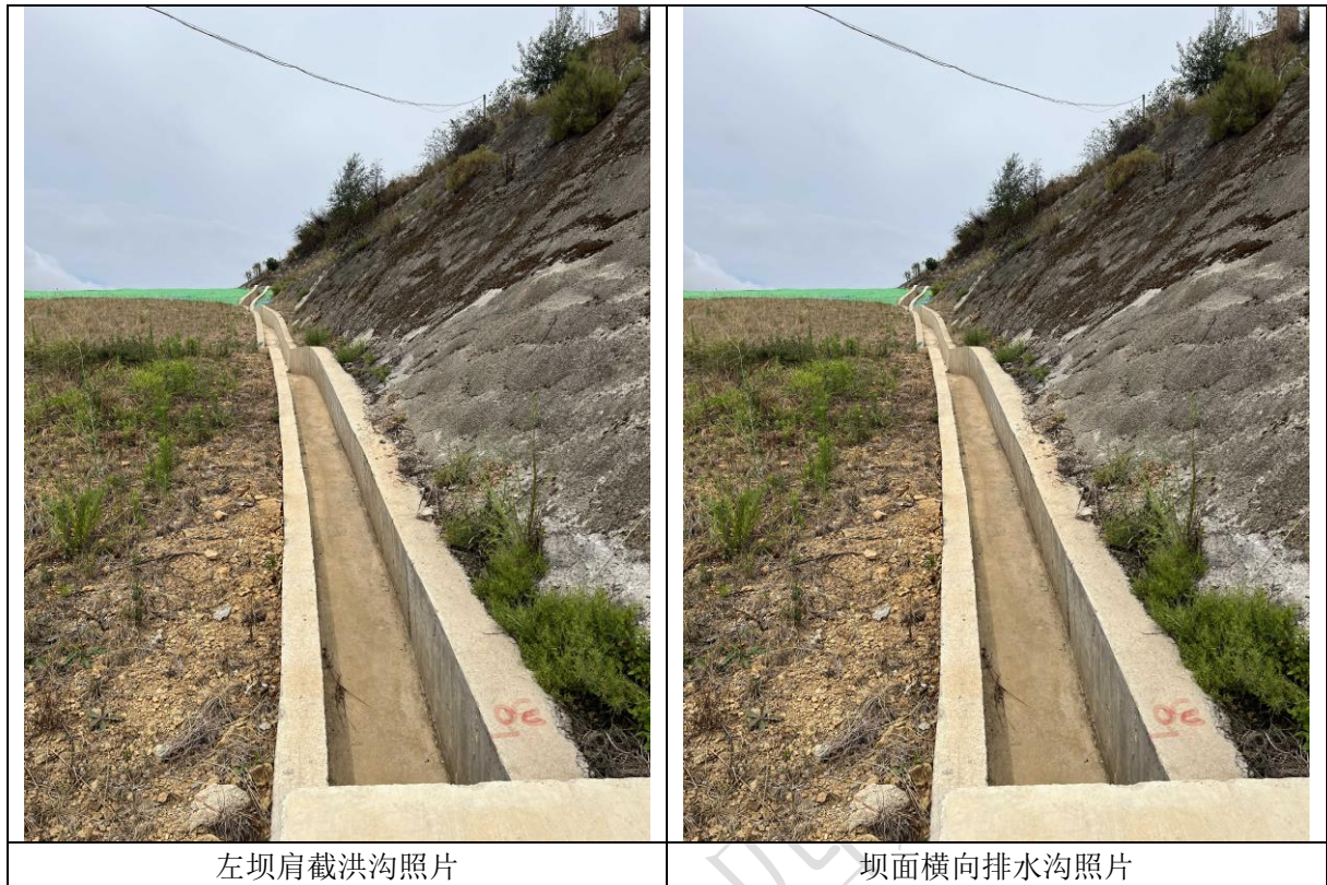
图 2.3-4 三排洪设施照片
