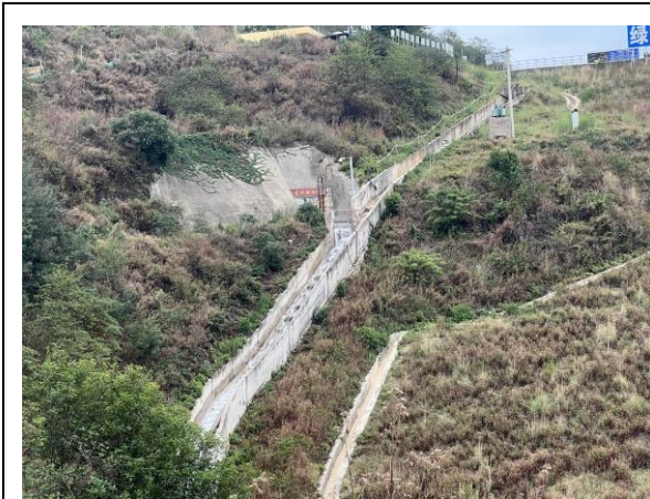
右岸岸坡截洪沟
